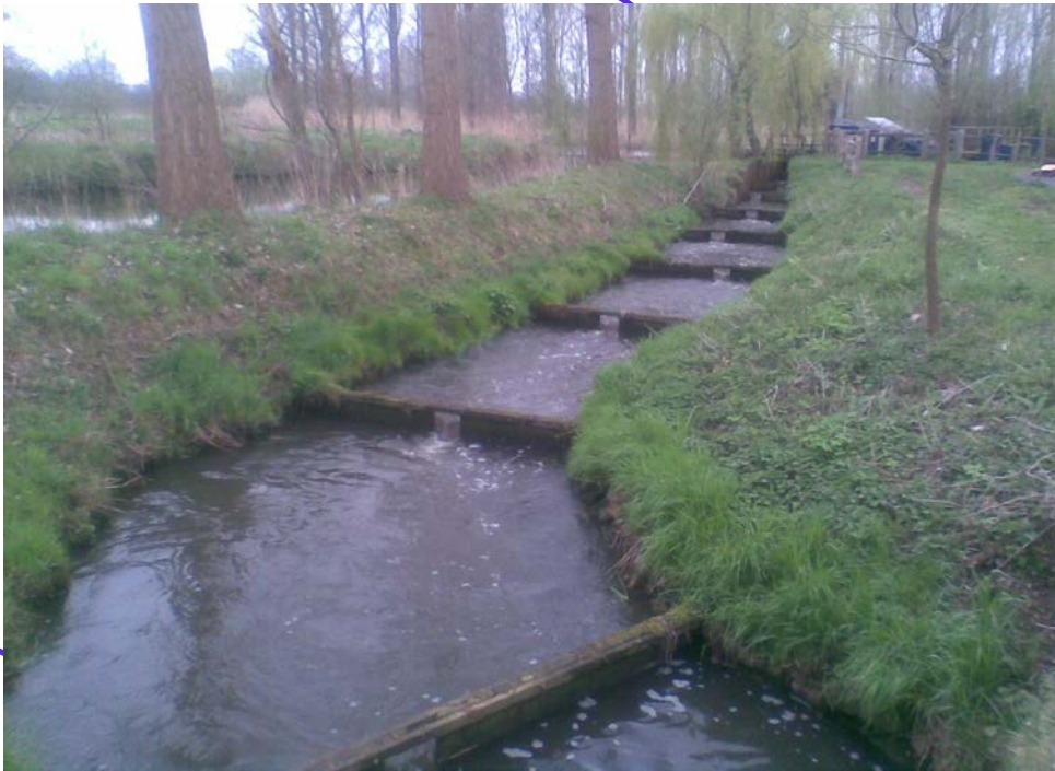
Afbeelding 5: 'Vertical-Slot'-vispassage bij de Hooionkse watermolen, uit Wouters, F., 'Visueel & hydraulisch onderzoek van vispassages voor Waterschap De Dommel', 2012.
